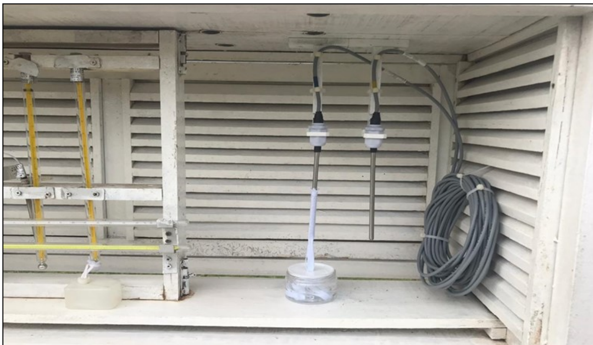
Pemasangan PT100 untuk wet bulb dan dry bulb Installation of PT100 for wet bulb and dry bulb
