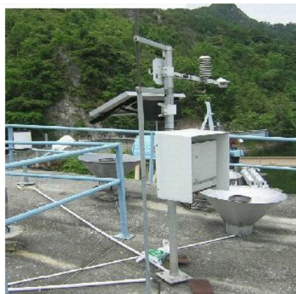
Ampangan Klang Gate
