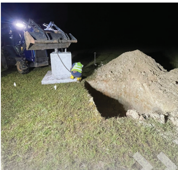
Kerja-kerja menanam pre cast
