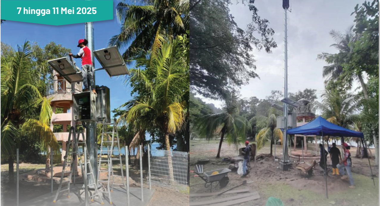
Kerja-kerja menaik taraf Siren Tsunami Teluk Nipah, Pulau Pangkor.
